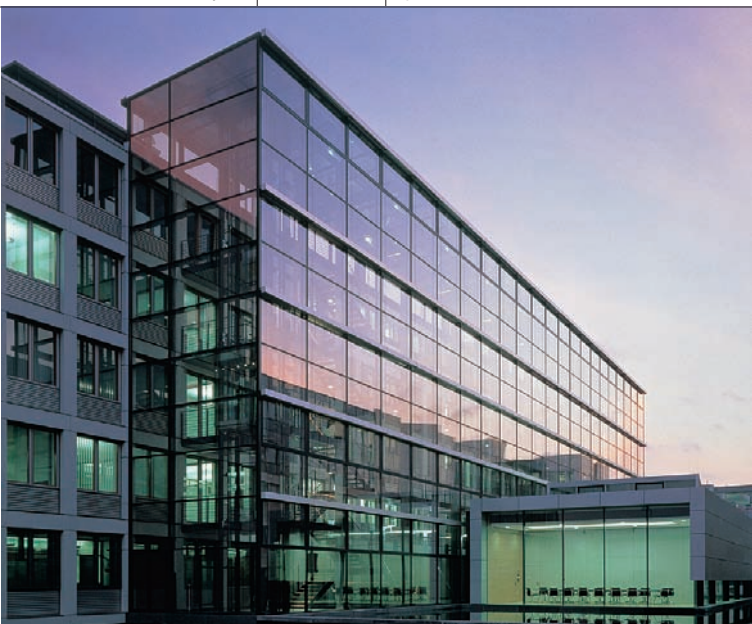
Verbundenheit mit der Sparkassen-Finanzgruppe demonstriert der Sparkassen Broker auch durch die Standortwahl: Die 112 Mitarbeiter teilen sich in Wiesbaden ein modernes Bürogebäude mit der Naspä.
